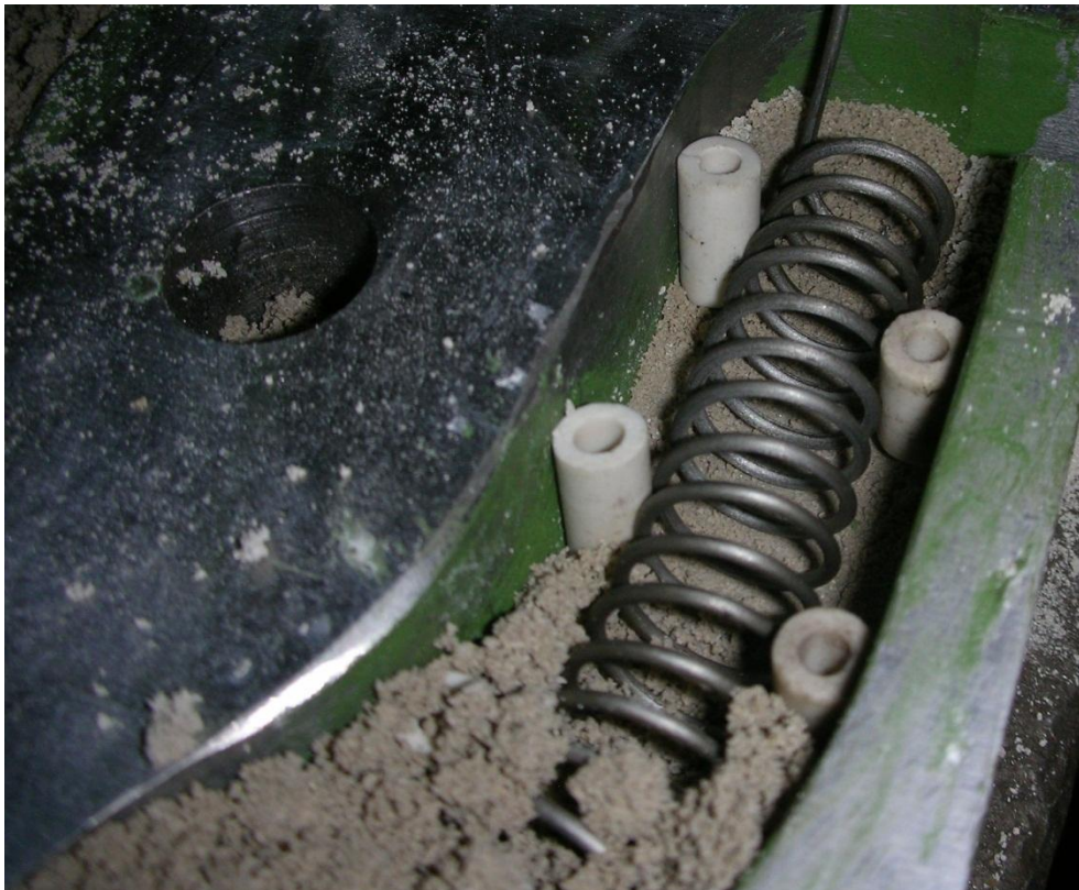
Рис. 1.3 – Монтаж омического нагревателя
